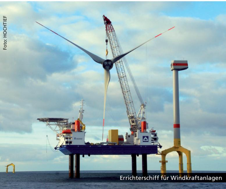
Errichterschiff für Windkraftanlagen
